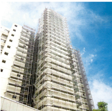
53mの施工実績写真
